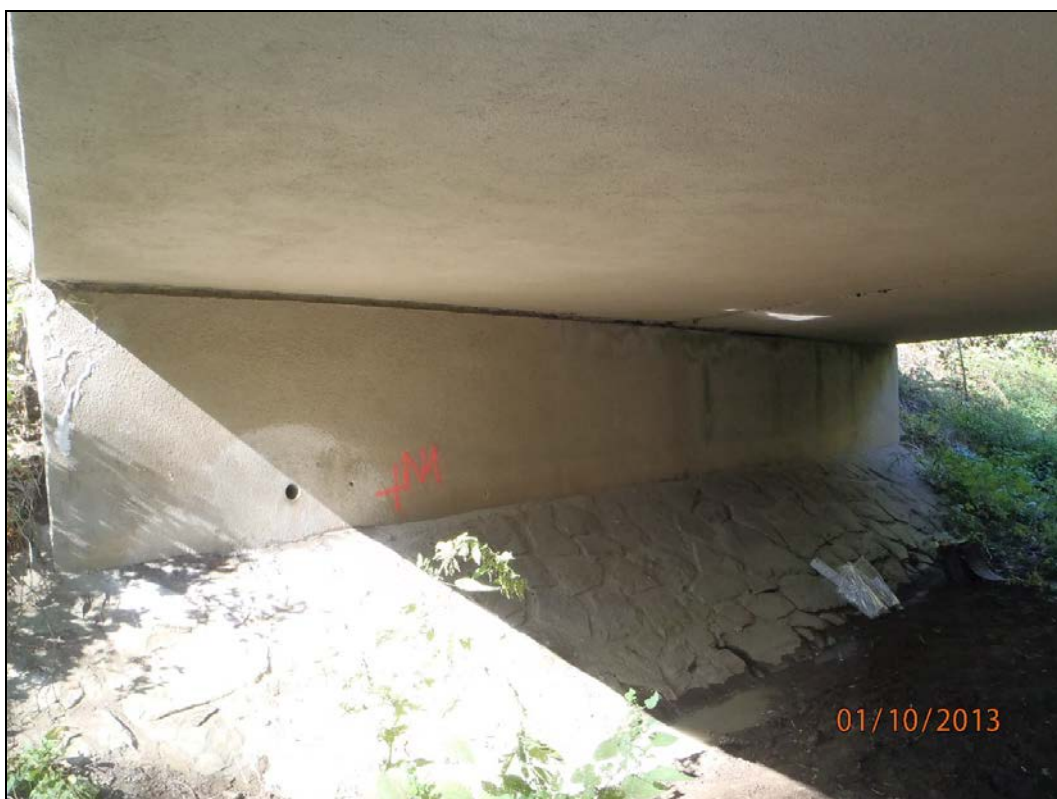
Obr. č. 3 - opěra Hustopeče, povrch opěry je bez poruch
