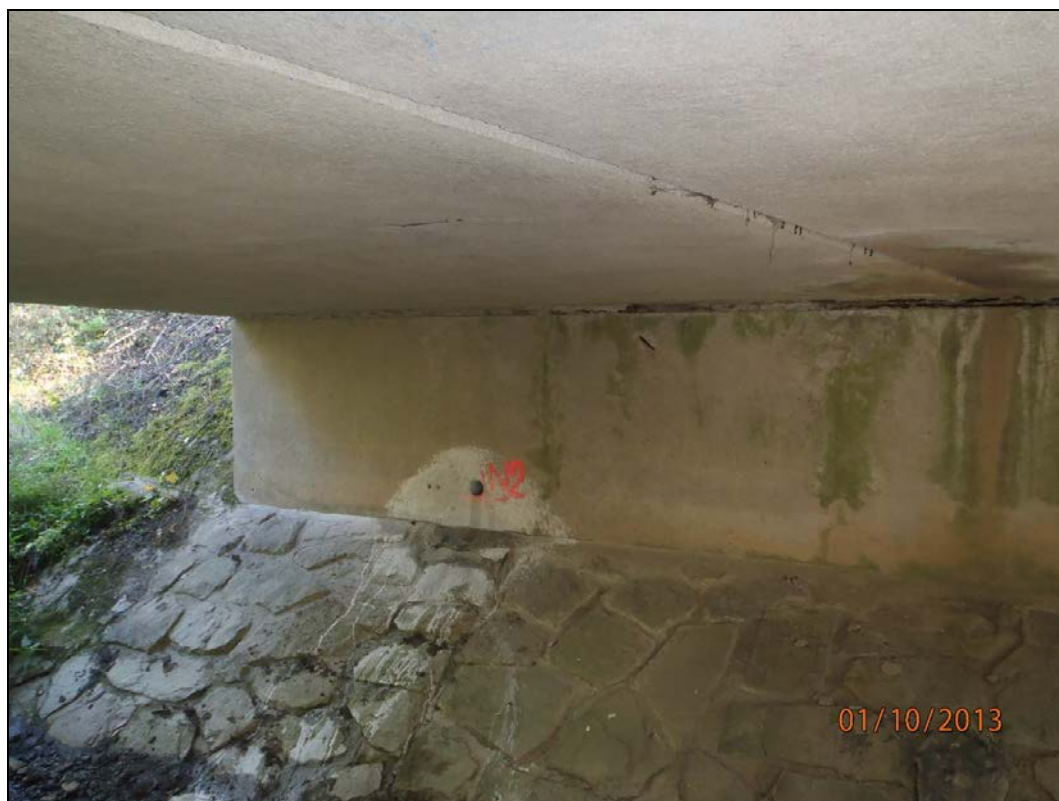
Obr. č. 4 - opěra Valašské Meziříčí, povrch opěry je bez poruch
